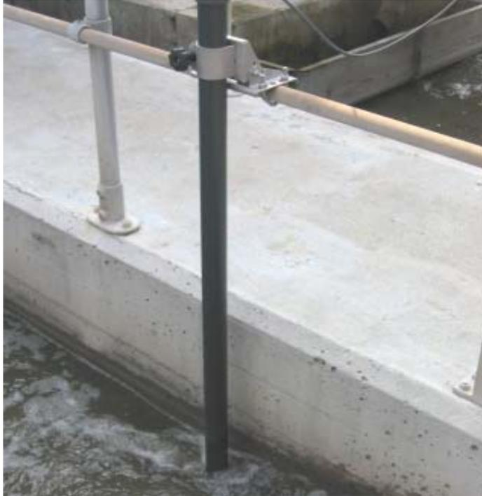
**Usando tubería PVC de 50 mm. o 1½",
